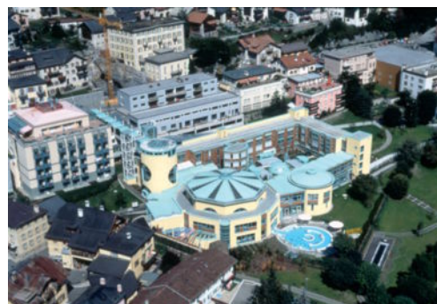
Vista del Centro termale di Bogn Engiadina a Scuol. Il campo di sonde è situato sotto la zona verde, a destra del complesso (foto Bogn Engiadina Scuol)
